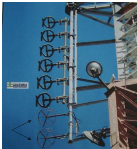
Figura 5 – Foto das antenas usadas nos testes; destaque para antena da transmissão digital
